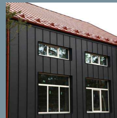
Отделка фасада фальцем
