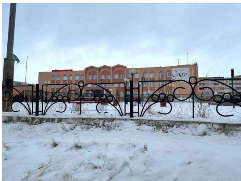
Плохо Излишняя вычурность
