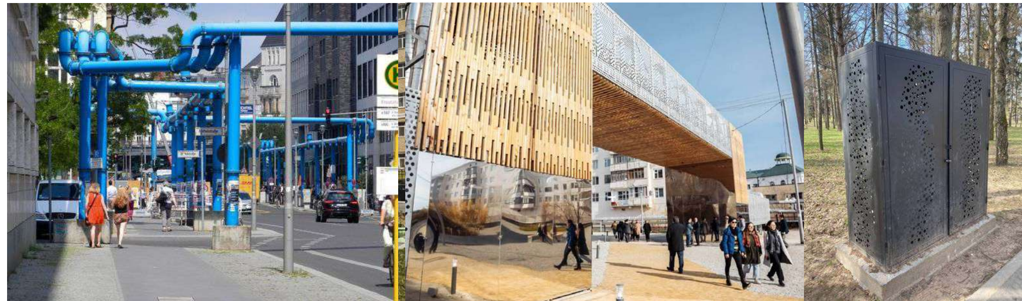
Покрасить в единый цвет все инженерные коммуникации: трубы, стойки, конструкции
